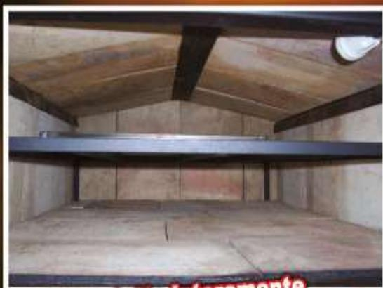
**tetto interamente rivestito in mattone refrattario**
