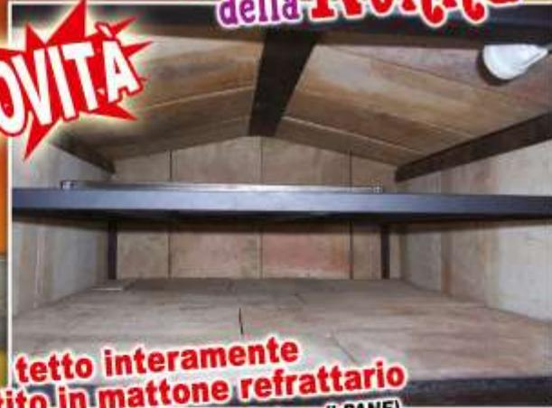
**tetto interamente rivestito in mattone refrattario**
